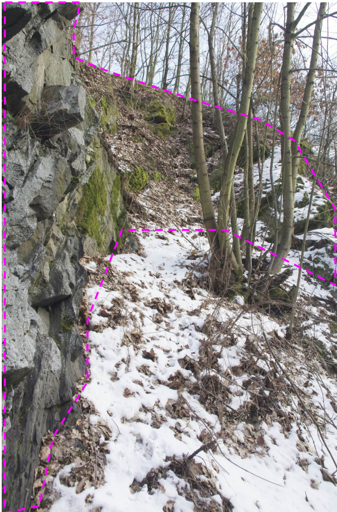
Foto – 9 Pohled do úžlabí vpravo v km 27,370. Karminová čára omezuje rozsah nutného zakrytí sítí v horní části s kotevními prvky.
