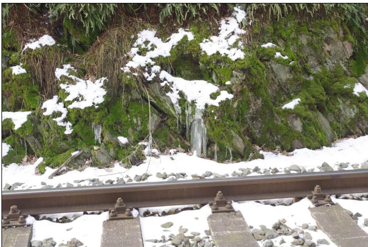
Foto – 11 Pohled vlevo v km 27,360 – 27,400 na zmrzlou vodu vytékající z puklin ve spodní partii skalní stěny.
