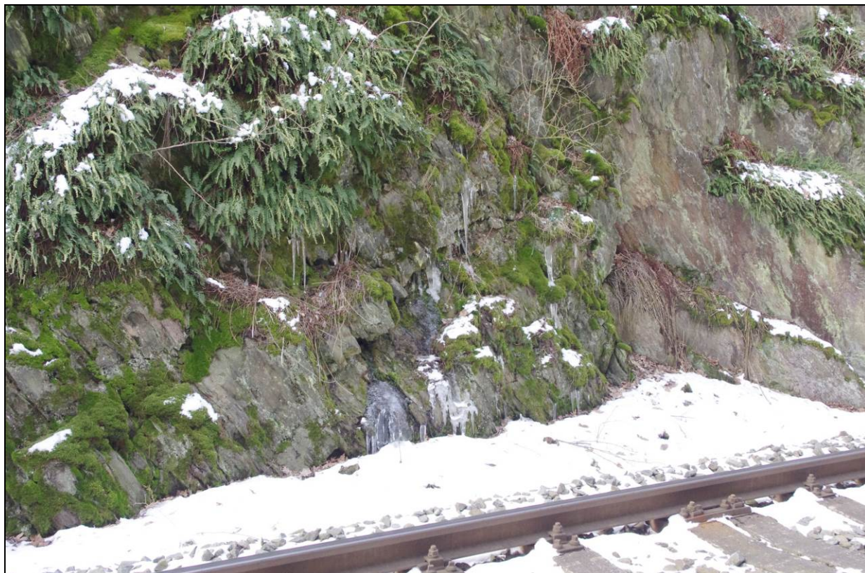
Foto – 12 Pohled vlevo v km 27,360 – 27,400 na zmrzlou vodu vytékající z puklin ve spodní partii skalní stěny.
