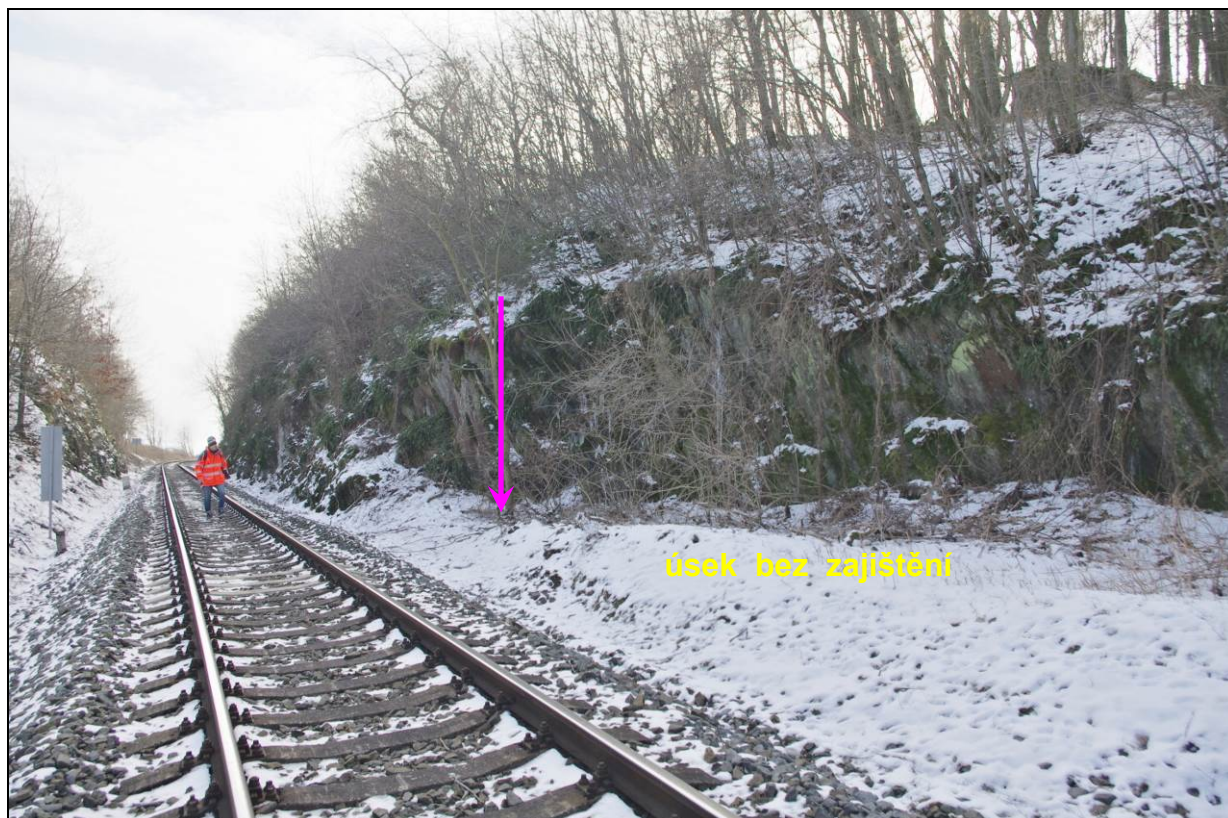
Foto – 15 Pohled do zářezu k Uničovu (proti staničení). Konec fortifikace skalního svahu vyznačuje šipka.
