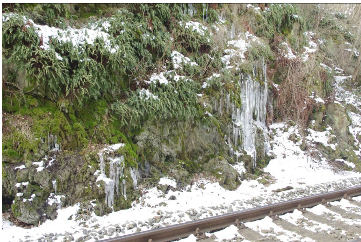
Foto – 13 Pohled vlevo v km 27,360 – 27,400 na zmrzlou vodu vytékající z puklin ve spodní partii skalní stěny. Rampouchy jsou zde na celé stěně.
