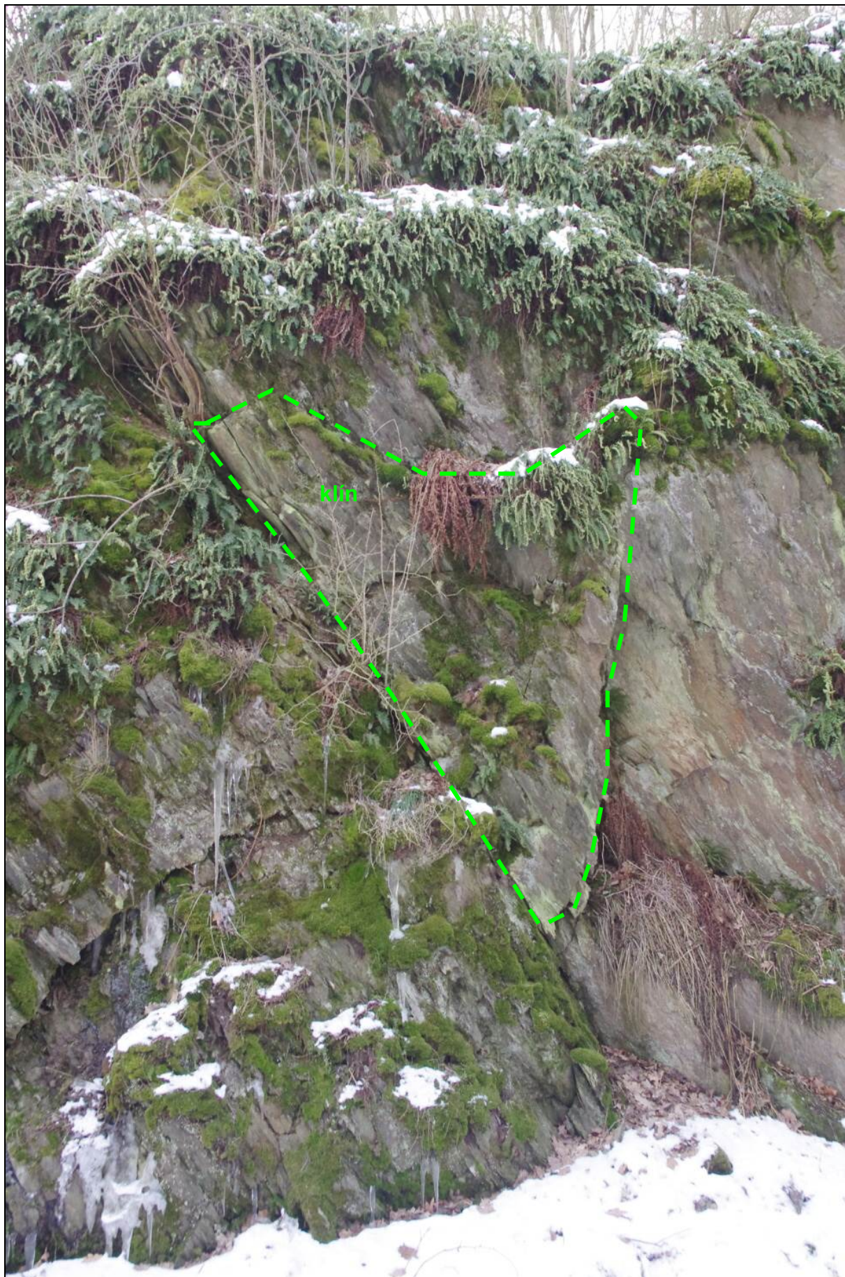
Foto – 14 Pohled vlevo v km 27,380 na vyjždějící klín horniny ze stěny.
