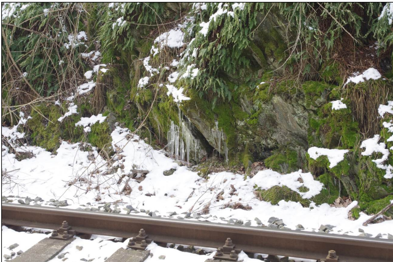
Foto – 10 Pohled vlevo v km 27,360 – 27,400 na zmrzlou vodu vytékající z puklin ve spodní partii skalní stěny.
